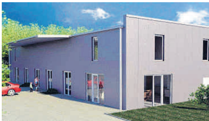
Die Halle wird in Sandwichbauweise errichtet. Grafik: Bouhs GmbH
